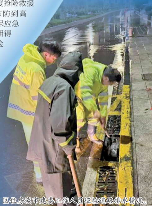
区住房城市建委工作人员巡查道路排水情况。
