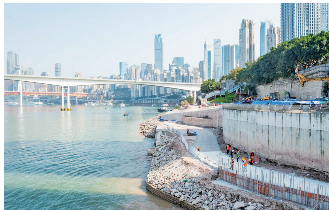
主城区“两江四岸”治理提升嘉陵江岸线贯通工程嘉滨路大溪沟段施工现场。记者 罗云希 摄
