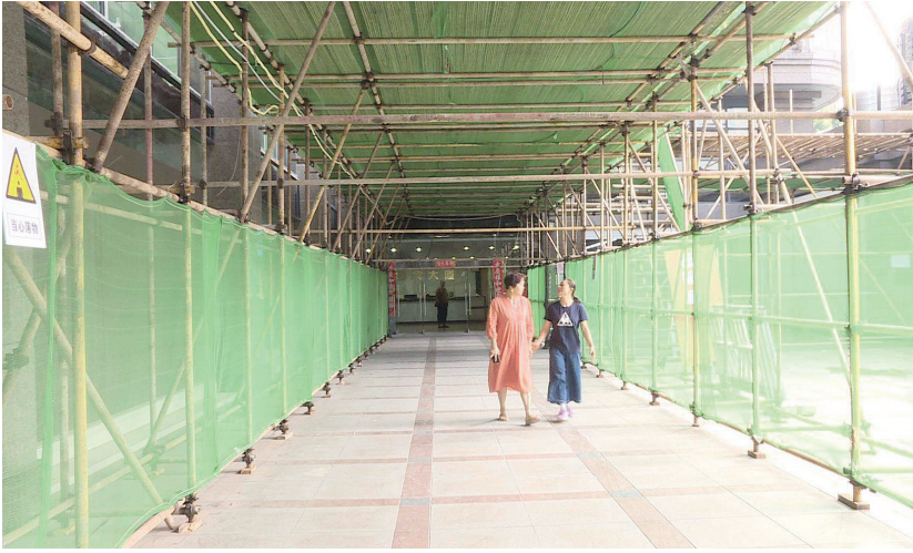
现场搭建了防护架,居民出行更安全。
