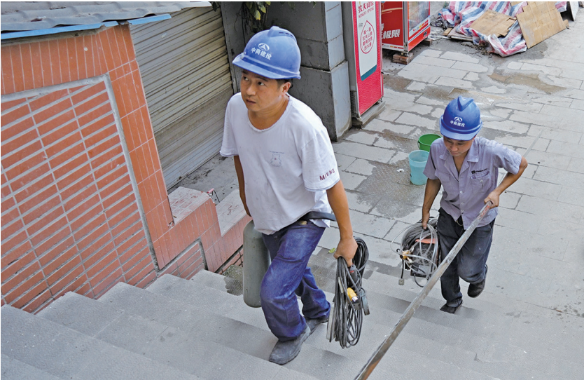
工人着手为居民安装新的晾衣杆。 记者 谭俊 摄
