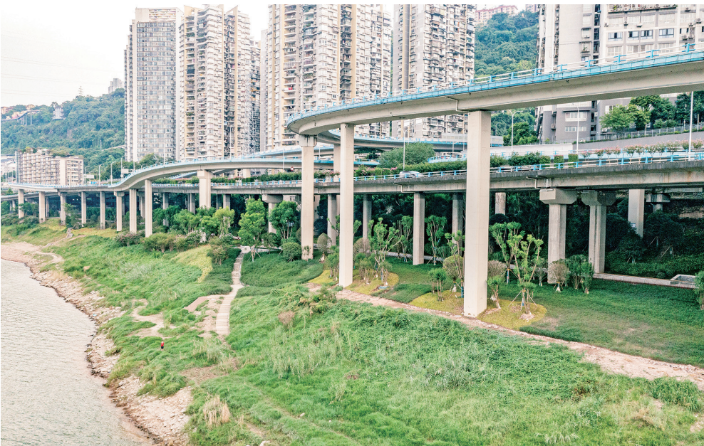
李子坝片区一“两江四岸”治理提升工程基本完工。
