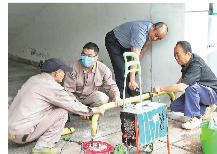
施工人员安装固定式隔离栏杆。 记者 李弋 摄
