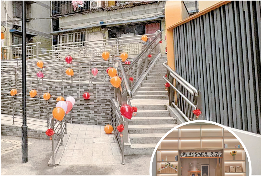
改造后的红星亭坡小区。
