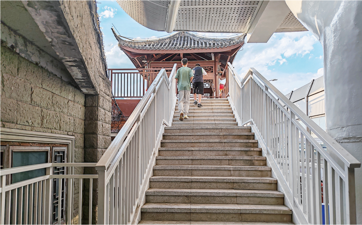
新开通的钢楼梯人行通道。
