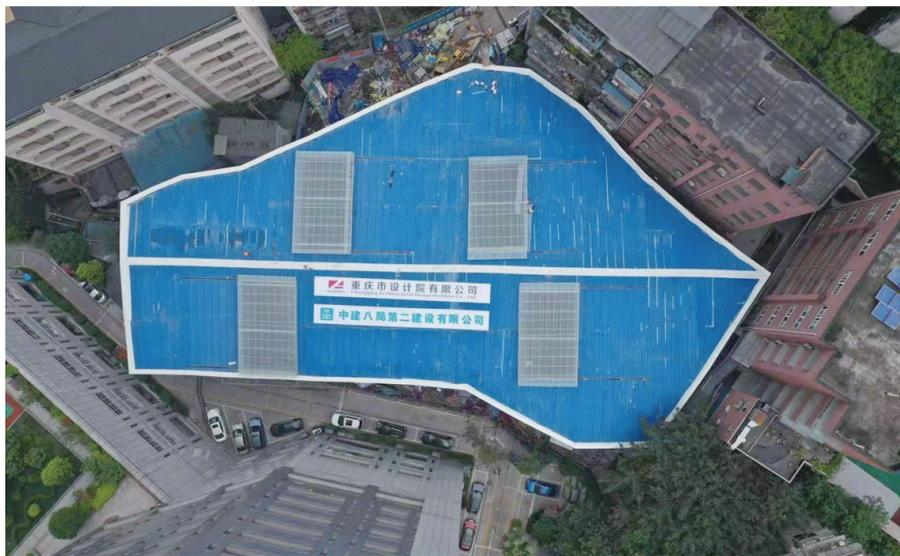
金马小学片区项目全覆盖式钢结构施工降噪棚航拍图。
